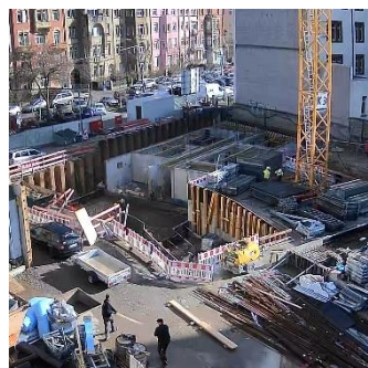
Blick in den zukünftigen Keller: ein kleines Labyrinth
