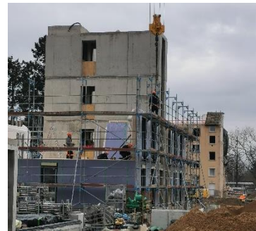
...wo dann rund um den massiven Treppenhaukern das Haus entsteht.
