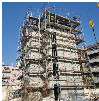
Der Trepphausturm Haus B: eine Etage pro Woche
